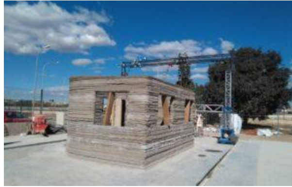
Figura 2.10: Impresora 3D con sistema de pórticos y cabezal móvil, tomado de www.elcomunicador.com , 2018.
