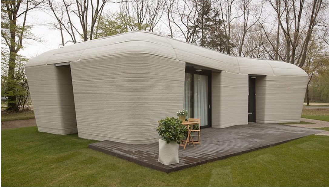
Figura 1.2 Primera casa construida con impresora 3d en menos de 120 horas con todas sus terminaciones en Holanda. Tomado de “La primera casa impresa en 3D en su totalidad está en Holanda” por María Tapia, 2021, https://www.expansion.com/fueradeserie .
