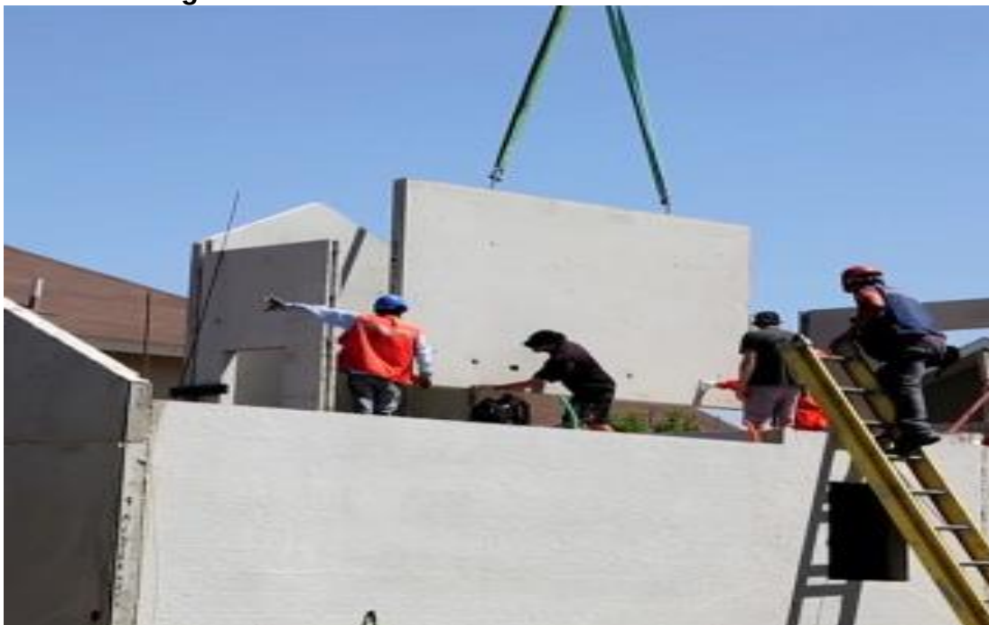
Figura 4.1: Construcción de vivienda BauMax
