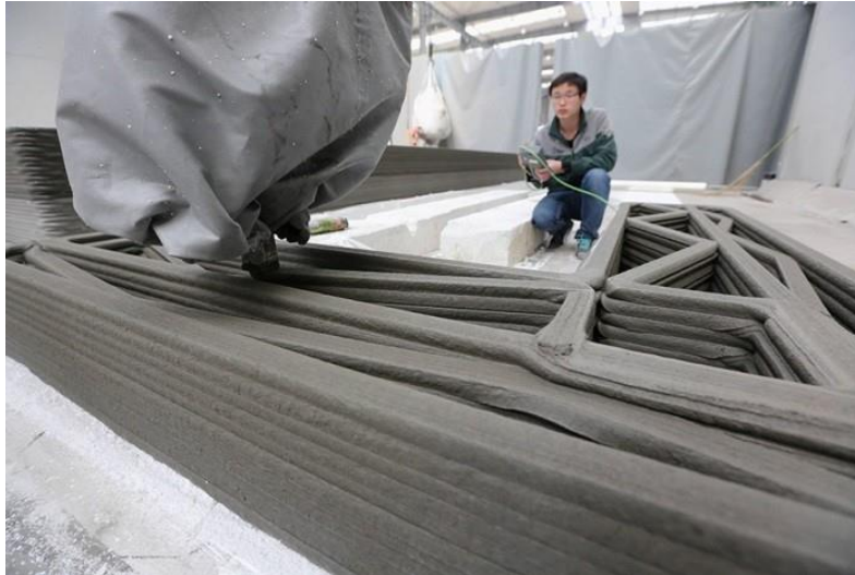
Figura 2.13: impresora 3d realizando esquinas en muros con relleno, tomado de https://www.archdaily.pe/pe/02-357233/en-detalle-sistema-de-impresion-3d-construccion-por-contornos/53607667c07a80d43c0000b4 , por Enzo Vergara ,(2014).
