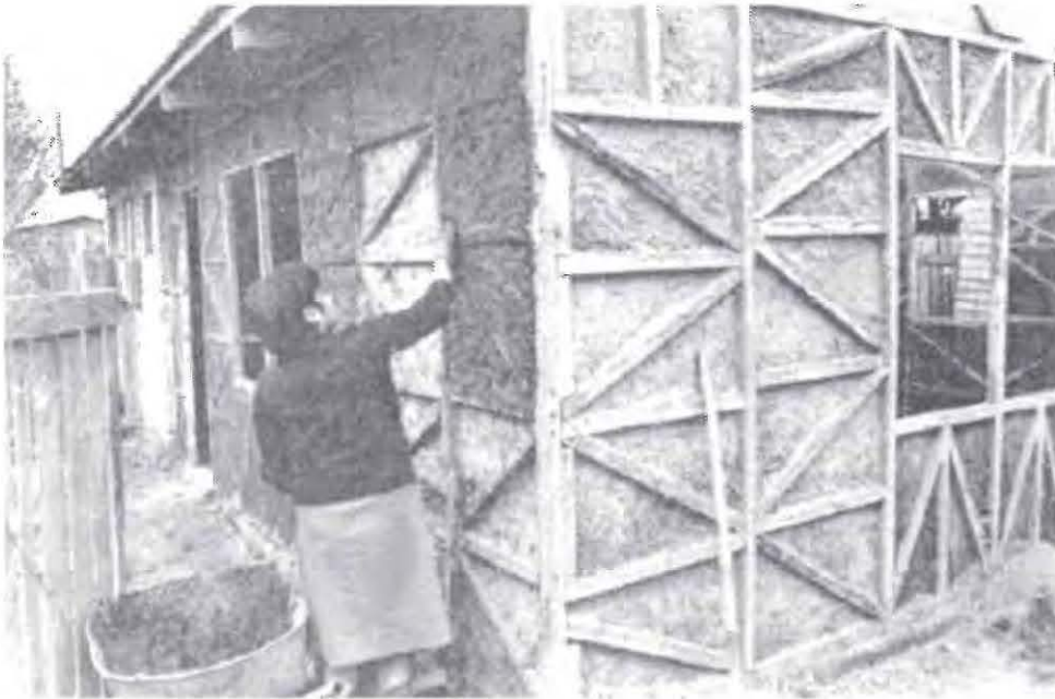
E. Tabiquería en tierra. Autoconstrucción
