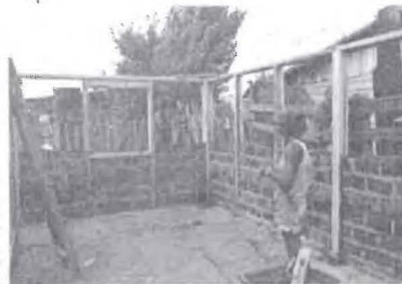
B. Construcción por Ayuda Mutua. Prefabricación con ladrillo.
