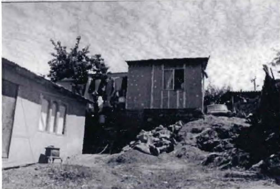
Acumulación y pérdida de materiales de construcción.
