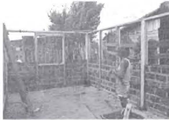
D. Construcción por Ayuda Mutua. Rehabilitación con ladrillo.
