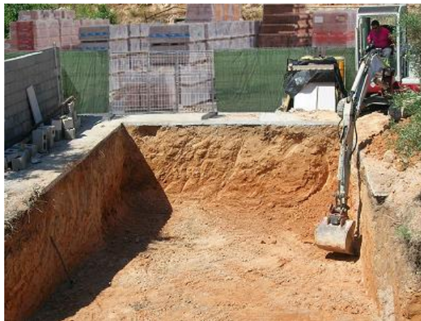
Figura 16: Excavación a cielo abierto con medio mecánicos. [Fuente: CYPE ingeniero, 2018]
