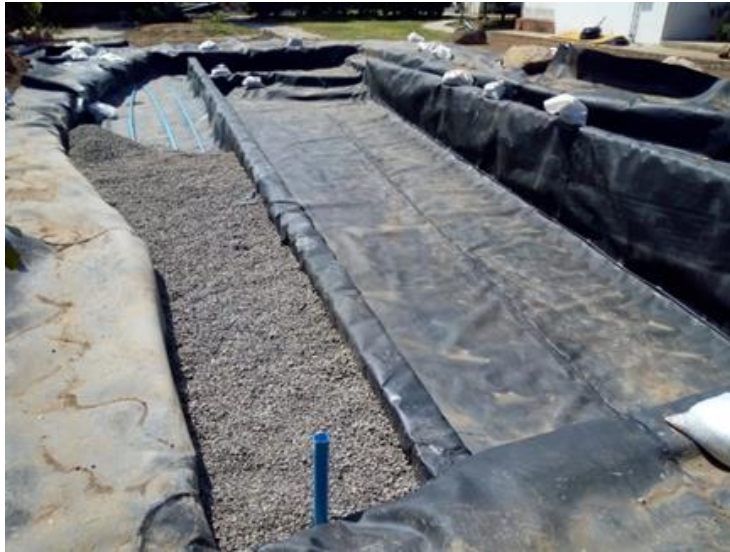
Figura 18: Ejemplo de instalación de geomembrana
