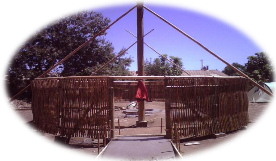
Fotografía N°6: Construcción Ruka Lawen.
