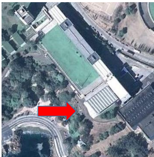
Ilustración 7.6: Lugar de instalación de planta de tratamiento de aguas grises
