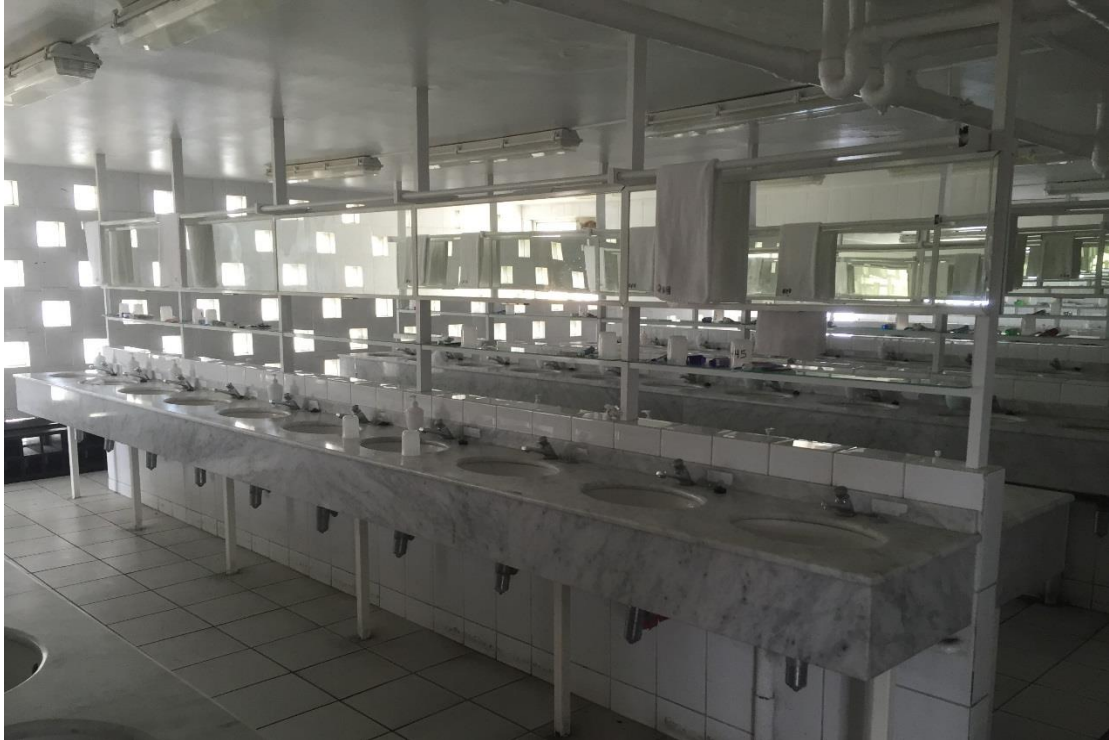
Ilustración 2.5: Interior baños Edificio Habitabilidad
