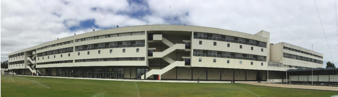
Ilustración 2.1: Edificio de Habitabilidad Escuela Naval "Arturo Prat"
