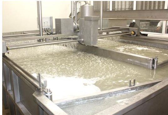
Figura 6 Piscina de salado. Fuente Tecnical, 2024
