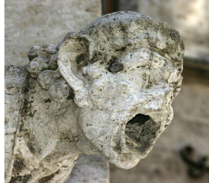
Escultura de mármol afectada por la lluvia ácida. (Imagen Google)
