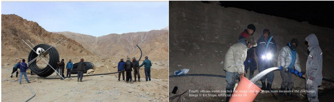
Figura 5.20: Instalación de tubería de suministro de agua en Ladakh. (Fuente: Ravibhanu & Christy, 2018)
