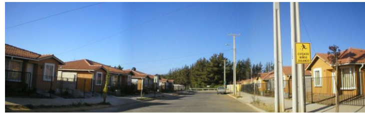
Condominio residencial junto a la quebrada.
