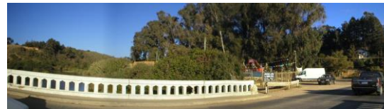
Puente Av. Mirasol.
