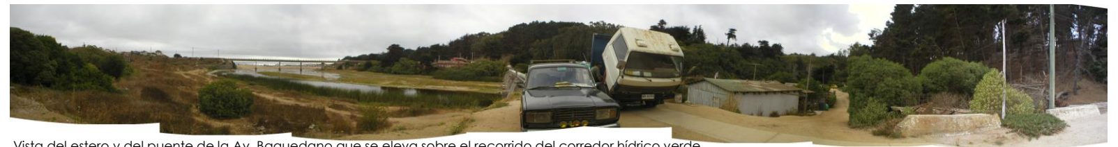
Vista del estero y del puente de la Av. Baquedano que se eleva sobre el recorrido del corredor hídrico verde.
