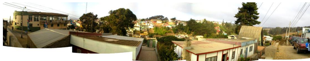
Vista sobre las viviendas hacia la quebrada .
