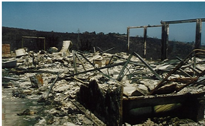
Figura 10: Destrucción de Infraestructura Poblacional a causa de un Incendio Forestal. En Chile, el Estado es responsable de la protección del patrimonio forestal, incluyéndose en este ámbito, la prevención y combate de estos siniestros.
