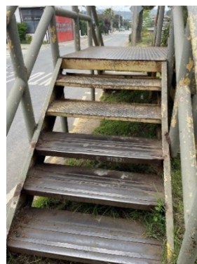
La huella es de 33 cm y contra huella 17 cm en escalera de Manuel Balmaceda.
