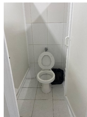
No cumple con la altura máxima de 48cm.
