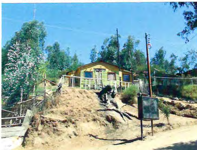
Fotografía N°3: Energía eléctrica Campamento Los Colonos
