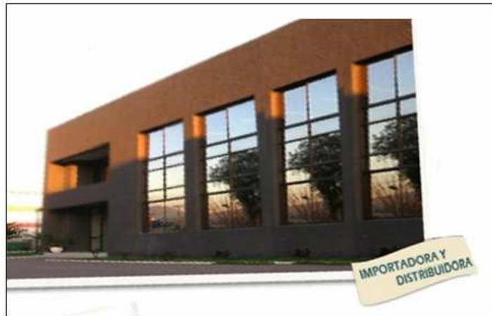
Figura 1.2- Centro de Distribución Fuente: Empresa Velarde Hnos.
