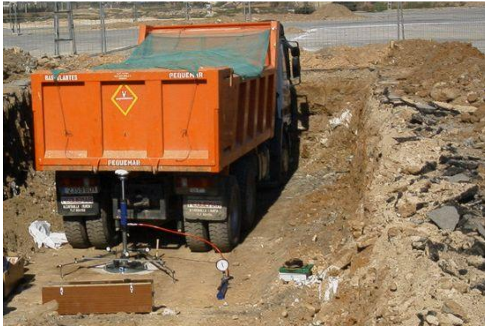
Figura 2.2 Ensayo placa de carga vista general, camión actuando de contrapeso
