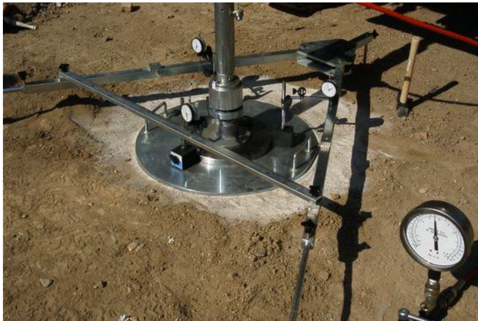
Figura 2.3 Ensayo de la prueba de placa de carga
