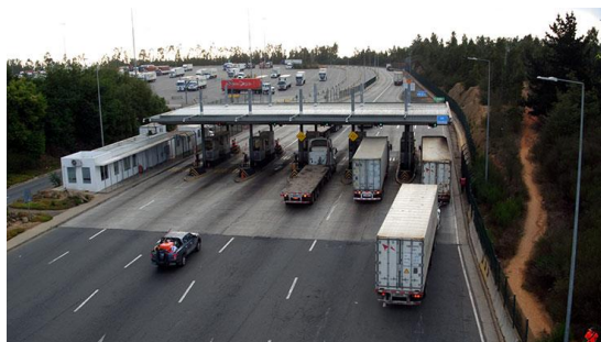
Figura 14: Pórticos de ingreso
