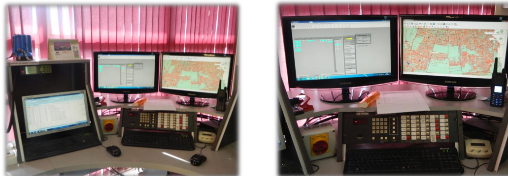
Fotografía 4.1 - Centro Operativo Cuerpo de Bomberos de San Bernardo
