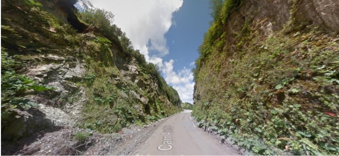
Figura 1.1 – Taludes y discontinuidades [11].
