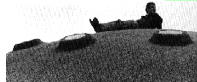
Fig. 21: Imagen de cubierta.
