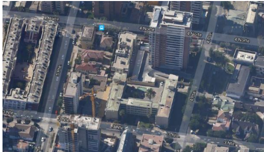
Edificio Verde Mar
