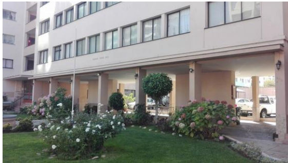
Edificio Verde Mar
