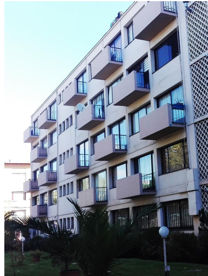
Edificio Verde Mar
