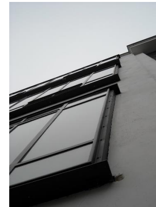
Detalle de ventana y acero
