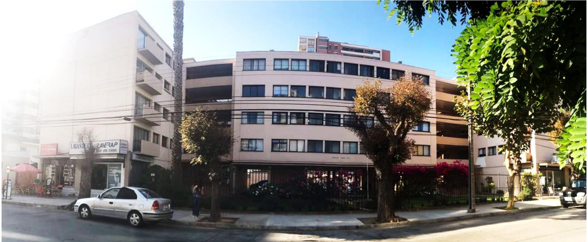
Edificio Verde Mar
