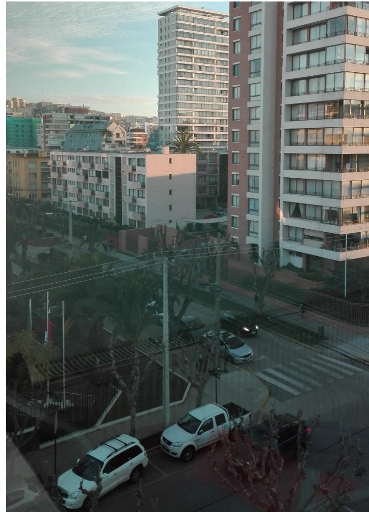
Edificio Verde Mar
