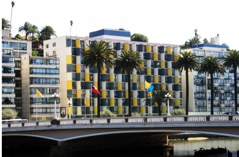
Edificio Copacabana Imagen 30
