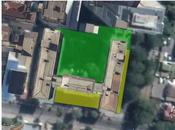
Edificio Verde Mar
