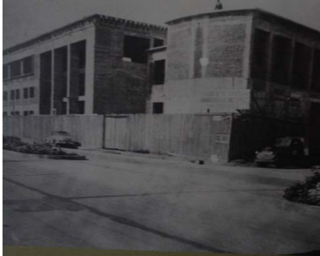
Imagen Ejecución Obras Edificio Escuela de Derecho.
