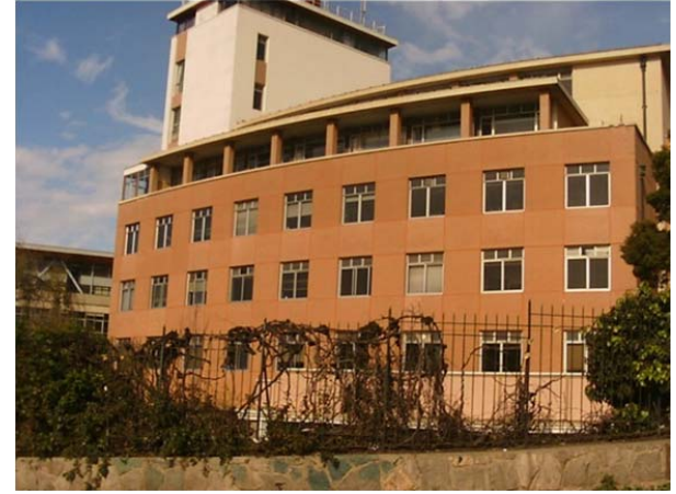
Imagen Edificio de Ciencias.
