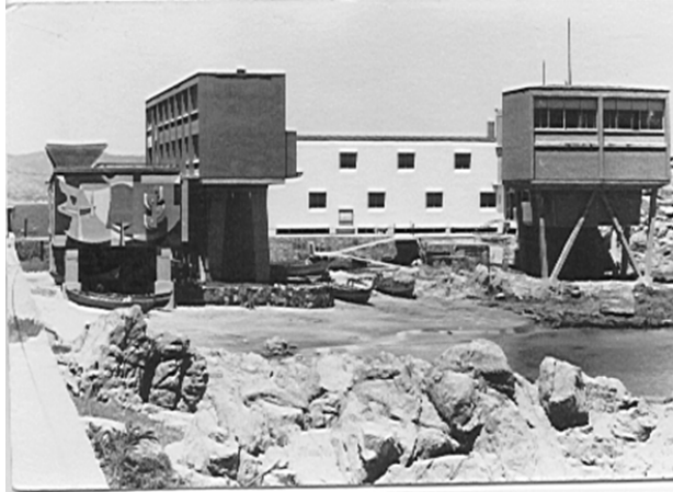
Imagen Primera Etapa Terminada.
