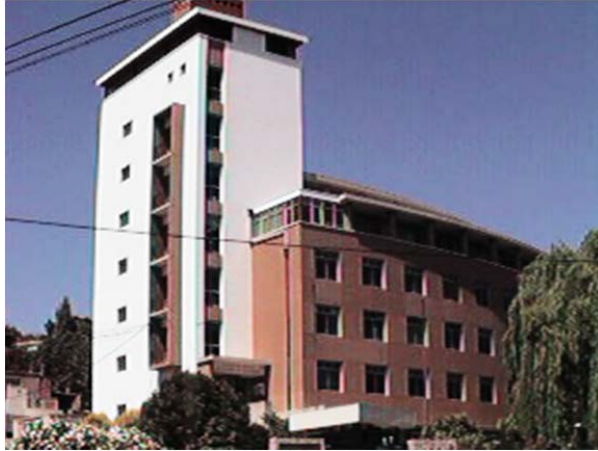
Imagen Edificio de Ciencias.
