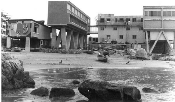
Imagen Construcción Tercer Nivel Laboratorios
