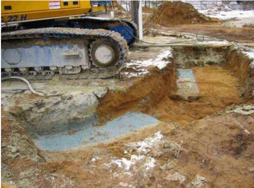
Ilustración 2.11 - pre-zanja en la fase inicial del procedimiento [12].
