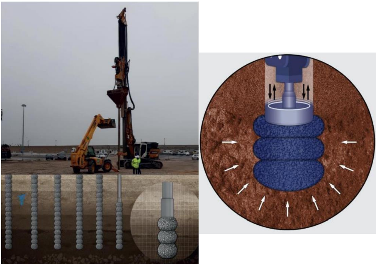
Ilustración 2.28 - Columnas de grava compactada, sistema RAP. [19]
