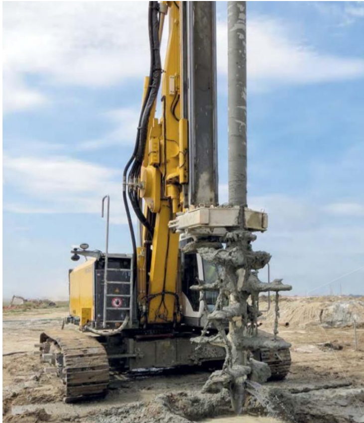
Ilustración 2.15 - Sistema de perforación SCM [13].
