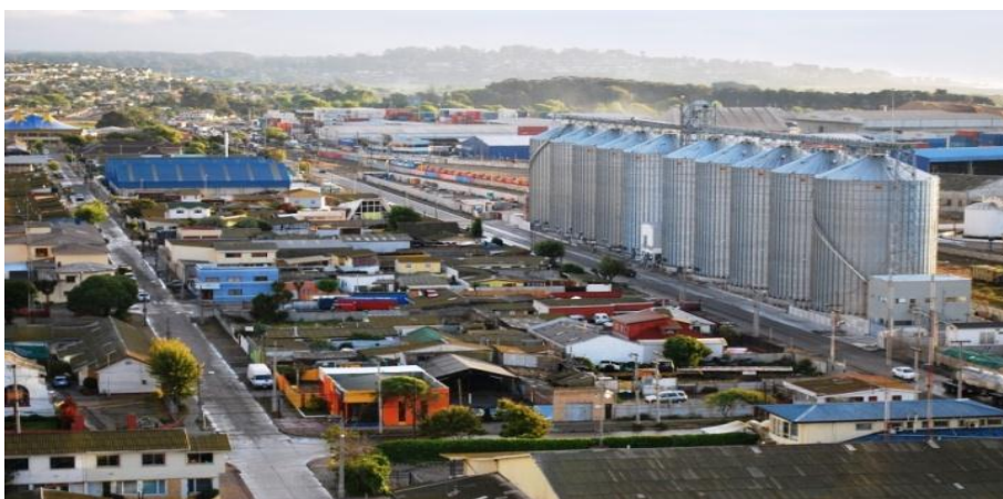
Figura 13. Instalación de silos
