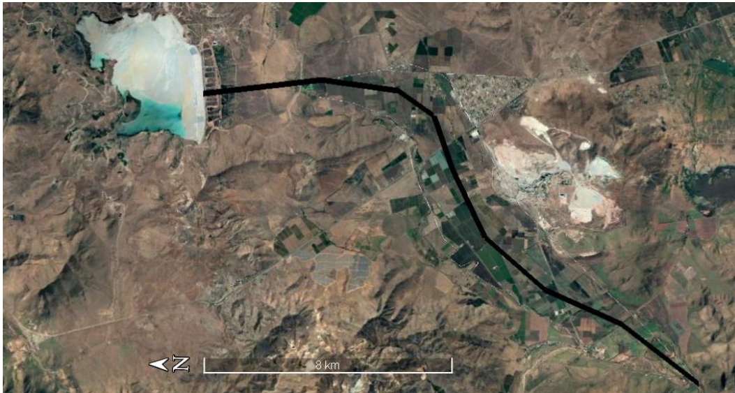
Figura 5.9. Distancia de peligrosidad estimada para el depósito Ovejera. Fuente: Google Earth, elaboración propia.
