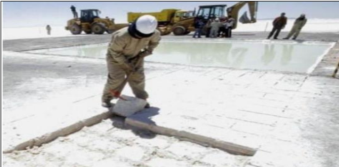
Figura Nro. 11 Fabricación de piscinas para la evaporación del Litio.
