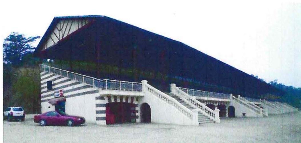
Imagen N° 502: Graderías de estructura metálica en el Valparaíso Sporting Club de Viña del Mar, del arquitecto Alfred Azancot Levy (1903-1910)
