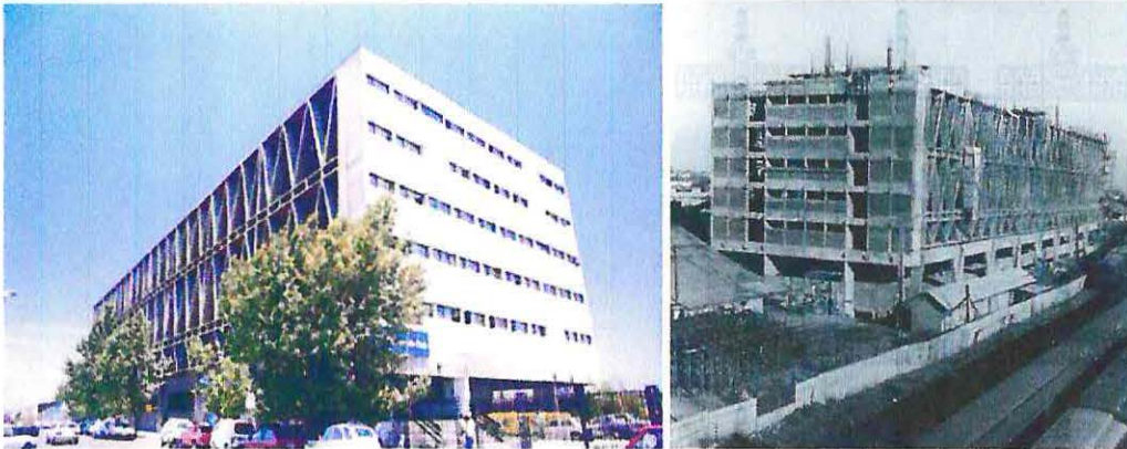
Imágenes N° 218 y 219: Edificio de la Central Clasificadora de Correos, en la Av. Exposición, obra de Boris Guiñerman Waissbluth. Vista actual y durante su construcción en 1967
