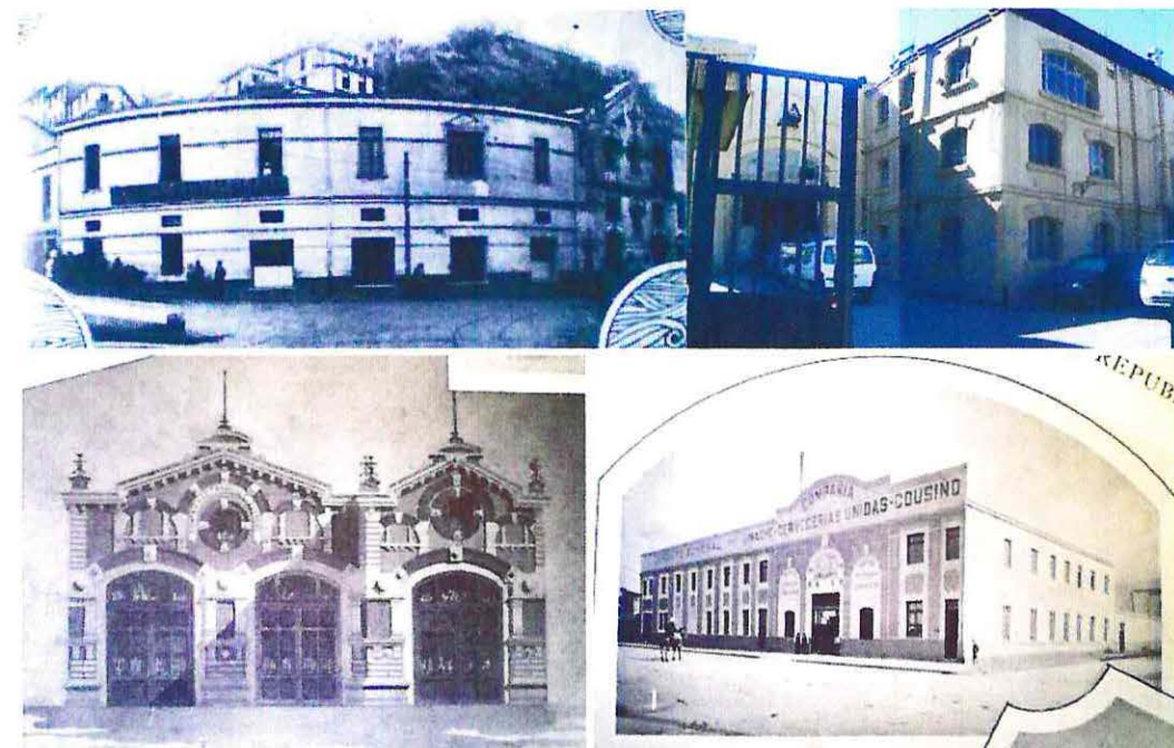
Imagen N° 344 (sup. izq.): Edificio de la Compañía de Gas de Valparaíso , calle Aldunate
