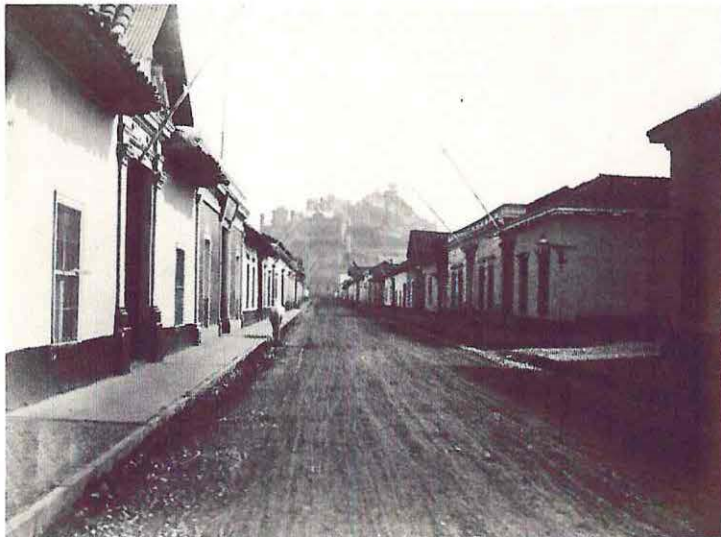
Imagen N° 91: Calle Huérfanos y Cerro Santa Lucía en 1874. Singular aspecto que ofrecía la imagen urbana colonial en las calles de Santiago durante el siglo XIX antes de la llegada del arquitecto Brunet Debaines a Chile
