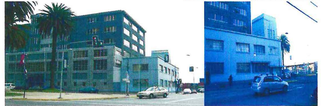
Imagen N° 400 (sup.): Edificio Industrial de Tres Montes S. A. C. , arq. José M. Rojas Gatica
