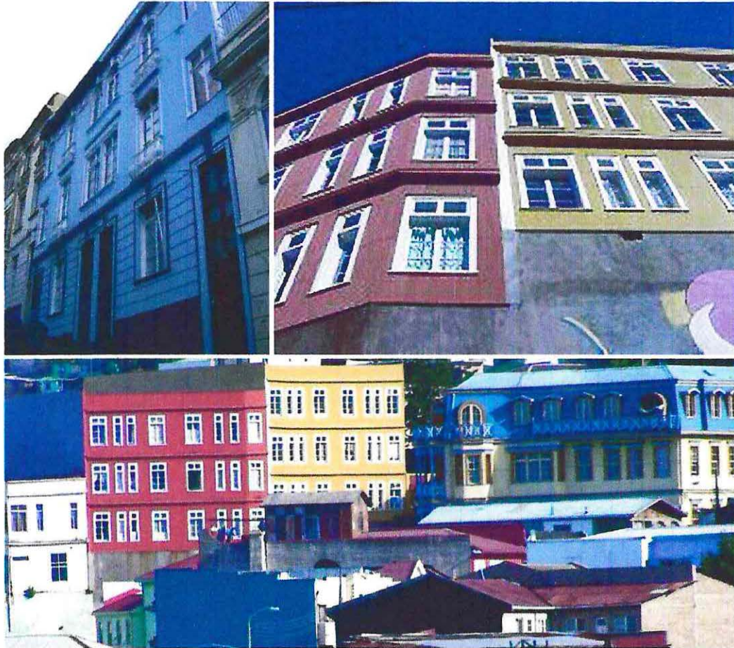
Casas de arriendo de don Manuel Domínguez, en las calles Pasteur, La Bruyére y Bellavista, en el Cerro Bellavista, construido por el arquitecto español Joaquín G. Barella Pavez (1912):
