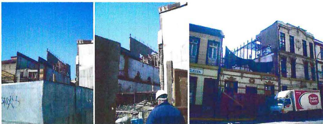
Imágenes N° 433 a 435: Edificios en demolición en calles Chacabuco y Yungay esq. Morris, construidos en los primeros años luego del terremoto de 1906 con fachada de ladrillo, ocultando su verdadera estructura en base a un esqueleto de pilares y vigas metálicas
