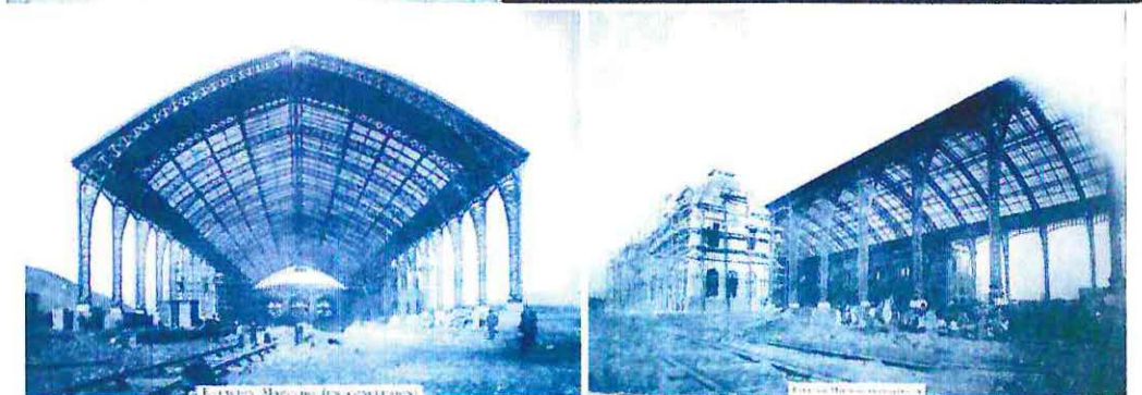
Imágenes N° 252 y 253 (sup.): Estación Providencia en construcción (1909) Imágenes N° 254 a 256 (centro e inf.): Estructura metálica de la Estación Mapocho durante su proceso de construcción
