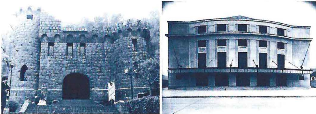
Imagen N° 136 (izq.): Estación Inferior del Funicular Cerro San Cristóbal, de L. Kulczewski Imagen N° 137 (der.): Teatro Oriente en Providencia, de C. Cruz Eyzaguirre y E. Munizaga Fuente fotografía 136: www.monumentos.cl • Fuente fotografía 137: www.puc.cl/sw_educ/archivodeoriginales
