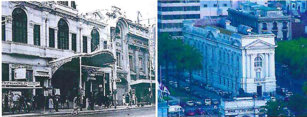
Imagen N° 310 (izq.): Teatros Victoria (actualmente demolido) e Imperio, Av. Pedro Montt Imagen N° 311 (der.): Biblioteca Santiago Severin frente a la Plaza Simón Bolívar
