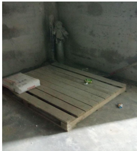
Figura 4.6 Centro de acopio provisorio sector escaleras Fuente: Propia (2023)
