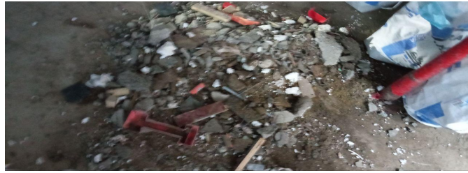
Figura 4.4 Residuos Mezclados Fuente: Propia (2023)
