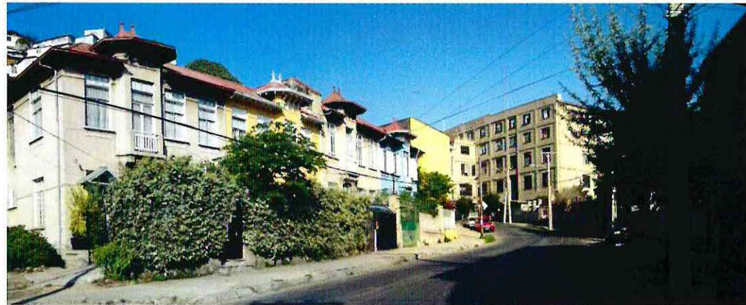
Imagen 44.- Villa de los obreros
