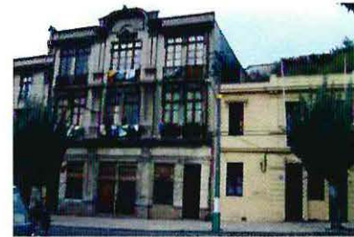
Imagen 39.- Edificio en Av. Francia
