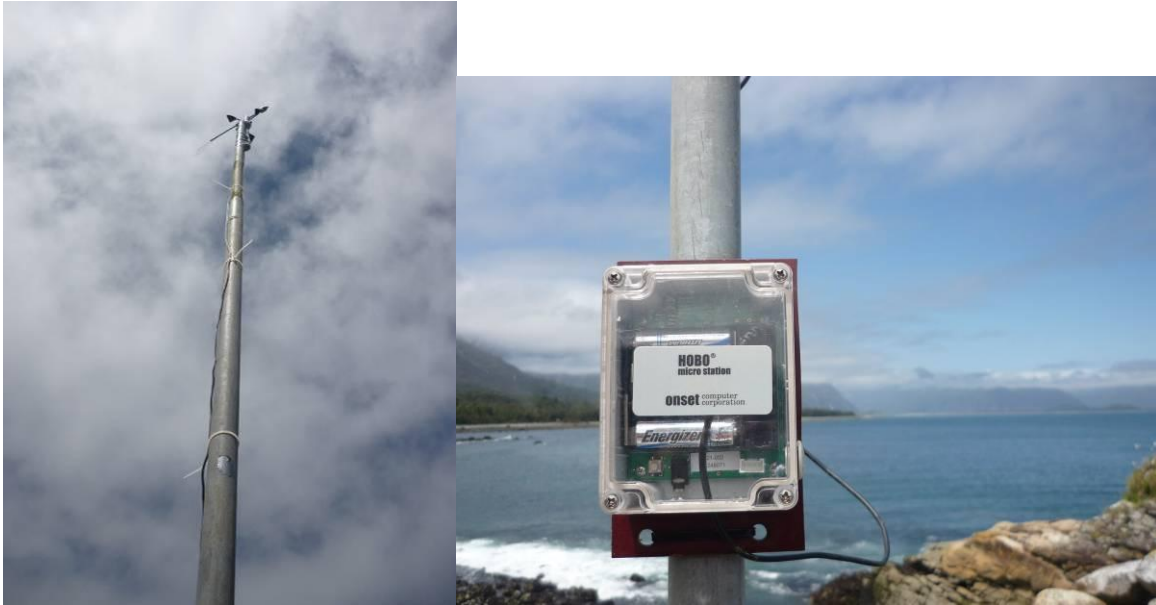
Figura 15: Estación Meteorológica Instalada en Fandango.
