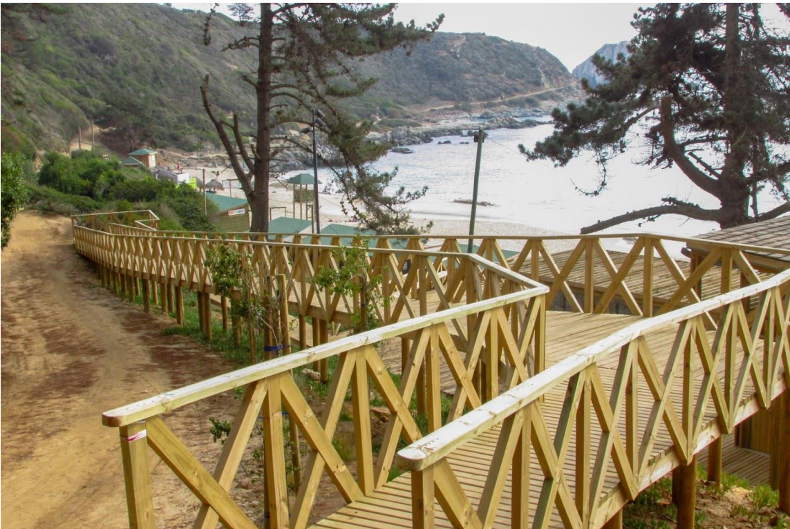
Fotografía N° 13: Playa el Canelo y pasarelas Parque Canelo - Canelillo
