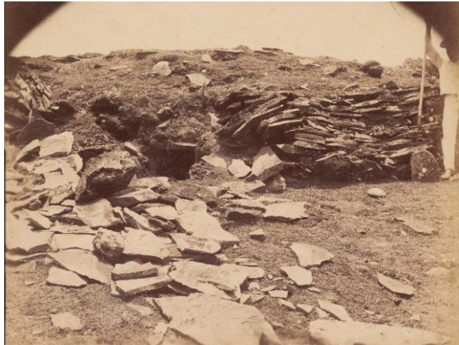
Fig. 29 Casa destruida no identificada. Fotografía de William E. Safford
