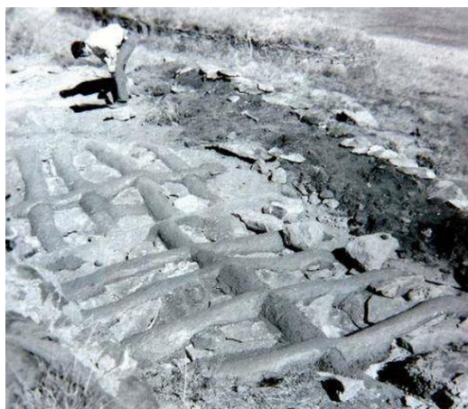
Fig. 64 Restauración del techo de la estructura 15a, reforzado con vigas de concreto
