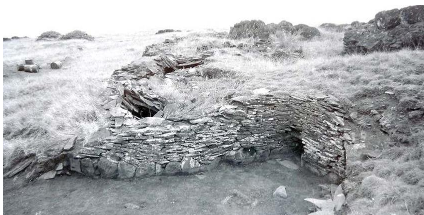
Fig. 62 La casa 15a con el techo y muro frontal derrumbado. Detrás, el techo colapsado de la casa 13.
