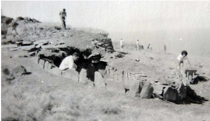
Fig. 60 Casa 3: instalación de las fundaciones del muro exterior.
