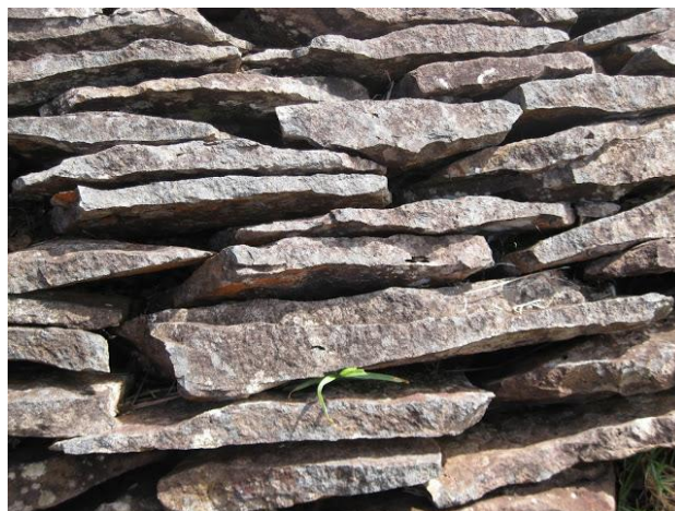
Fig. 82 Superficie del muro exterior de una casa de Orongo: keho
