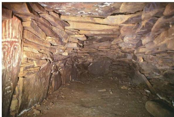
Fig. 83 Techo de falsa bóveda en el interior de una casa de Orongo (Budd y Vargas 1992)
