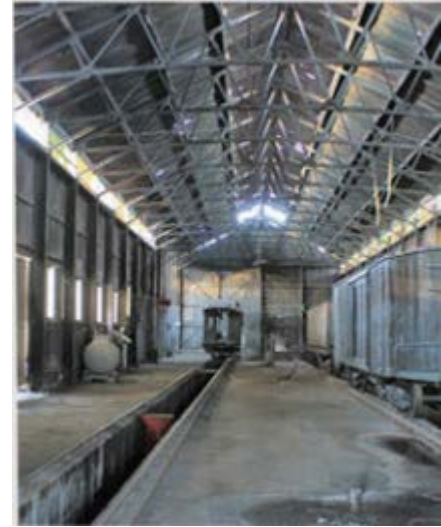
Fig.49: Lo industrial y la estructura expuesta / Ferrocarril Ollague, segunda región.
