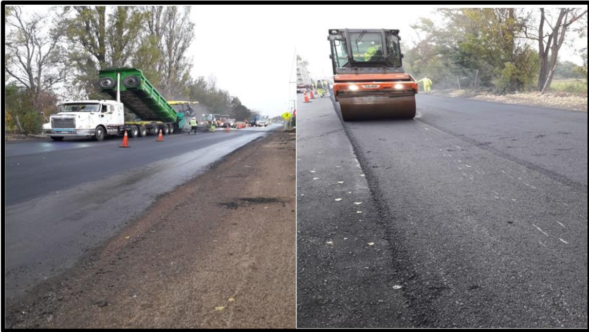
Figura 411 - Trabajos de recapado con y sin fibra.
