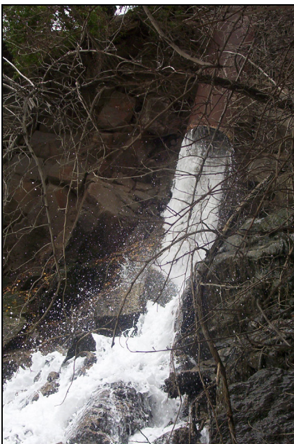
Figura 5. Descarga RILes Planta de Molibdeno, Estación 3.
