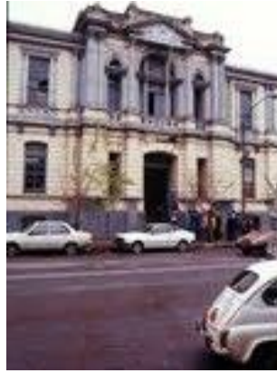
Figura 1 Hospital San Juan De Dios
