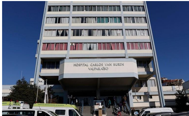
Figura 2 Hospital Carlos Van Buren. Edificio Quirúrgico
