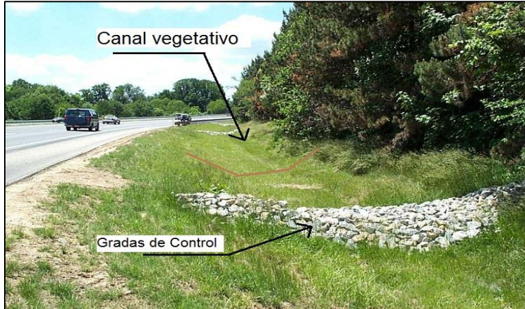
Figura 2.19 – Canal Vegetativo de sección trapezoidal, con gradas de control y vegetación nativa del sector, ubicado al costado de carretera. (Fuente: adaptado de [13]).
