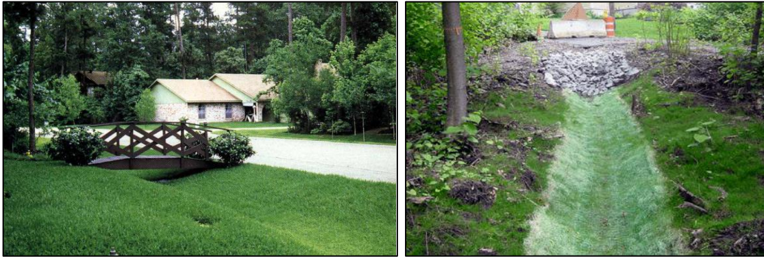
Figura 2.17 – Ejemplos de canales vegetativos. (Fuente: de [4]).
