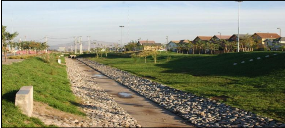
Figura 2.20 – Estanque de almacenamiento de aguas lluvias en Valle Norte, Santiago. (Fuente: de [4]).
