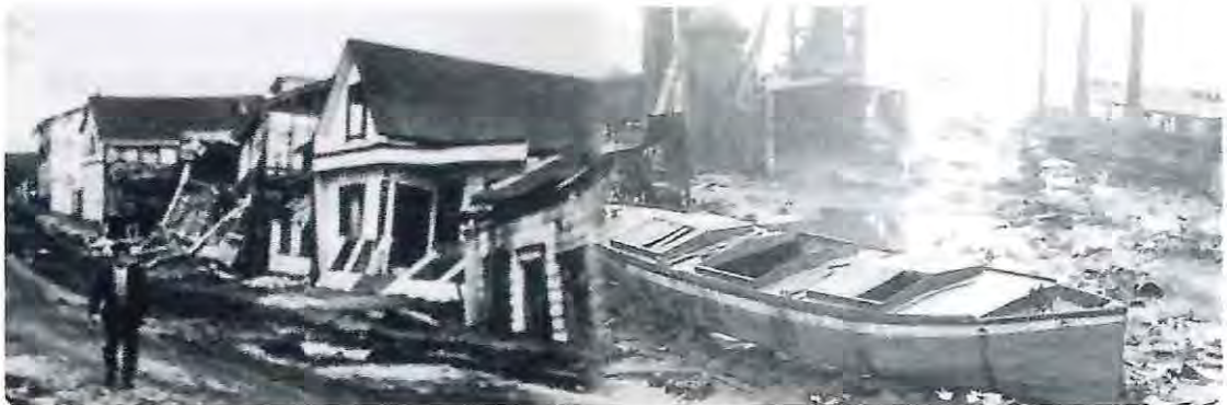
Ilustración 10: Estragos del Terremoto de Valdivia
