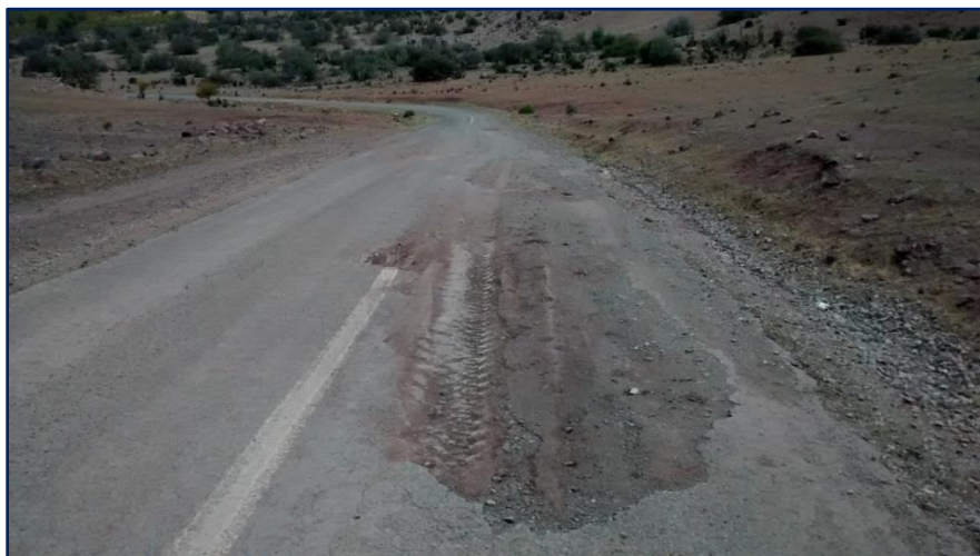
Figura 2.12: Baches Abiertos en Carpeta con TSS
