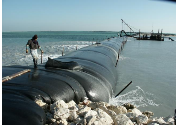
Figura 4-9 Geotubos Fuente: Topografho (2017)
