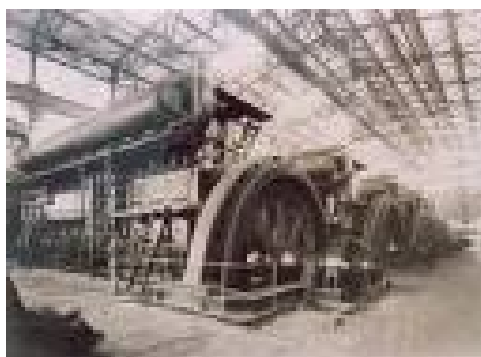
Maquina de fuerza Oficina Pedro de Valdivia
