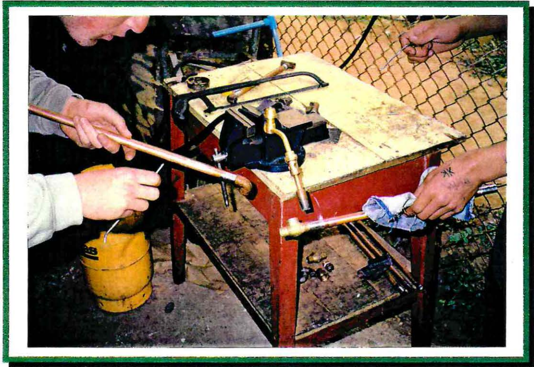
Proyecto N° 1: Sub Proyecto: "Taller de Destrezas Laborales". Jóvenes Trabajando en Taller de Gasfitería, aprendiendo a soldar y estañar cañerías de cobre.
