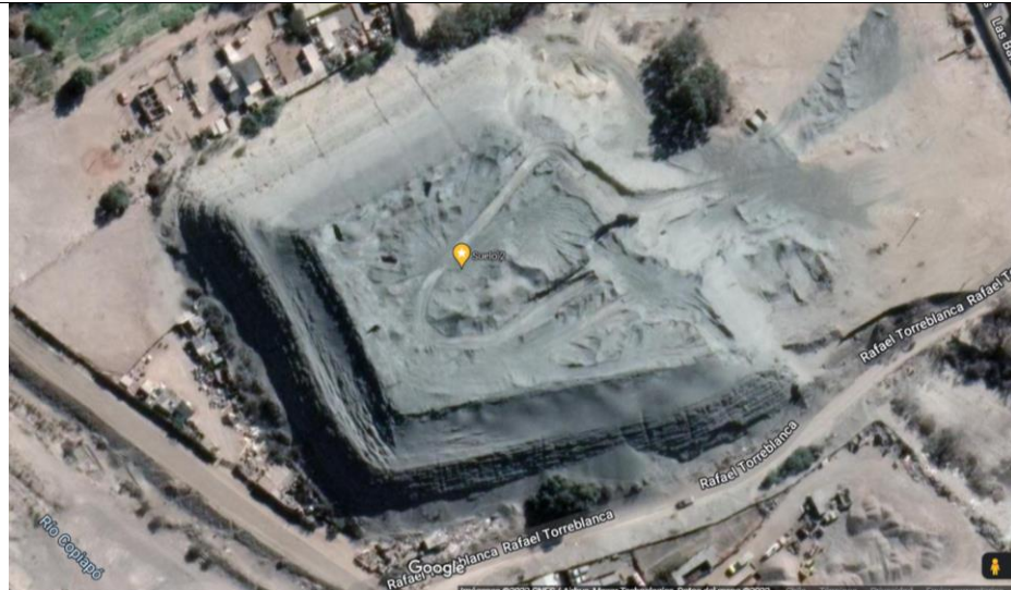
Figura 5.22 Vista aérea del relave de donde se sacó el suelo 2.
