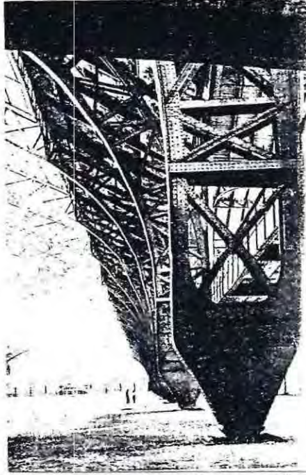
24. Apoyo Marco ESTRUCTURA METALICA EN PALACIO DE LAS MAQUINAS, 1889.
