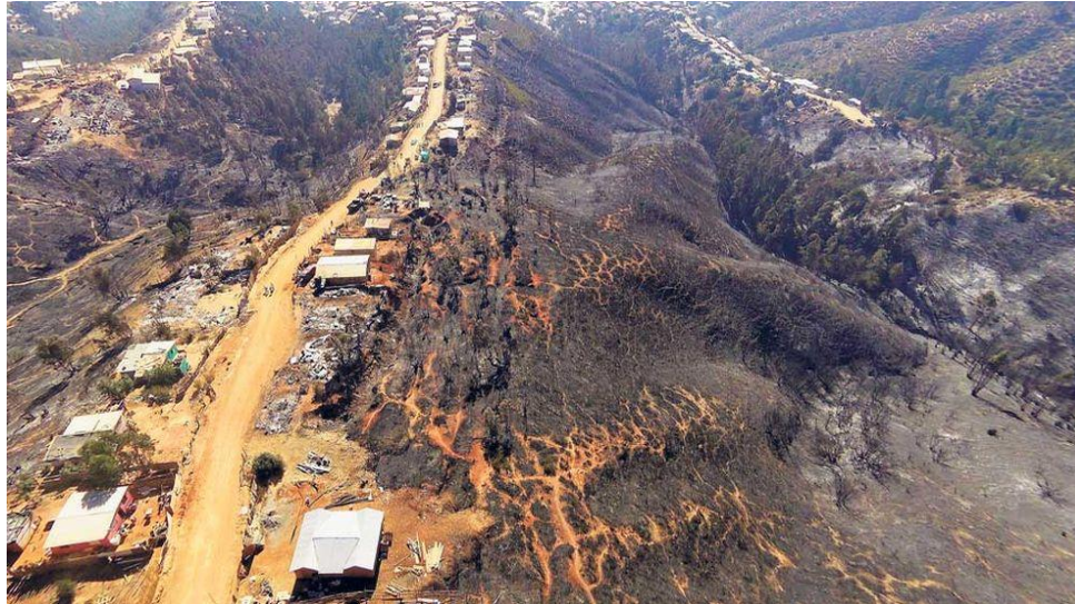
Figura13. Calle de cima delgada en Cerro Mariposa, zona periférica.
