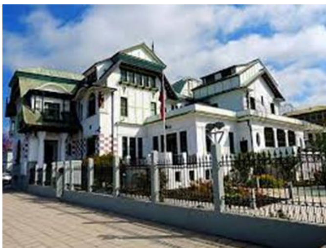
Figura 8: Vista actual del Palacio Baburizza. Fuente: Archivo Museo Municipal de Bellas Artes Palacio Baburizza.
