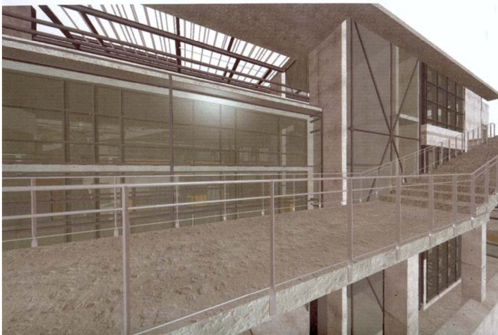
Vista circulación peatonal
