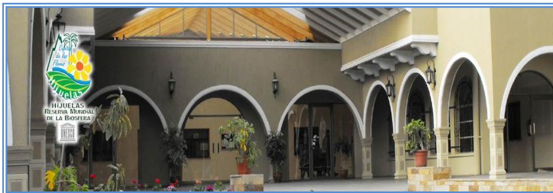
Figura 3.2. Fachada de perfil frontal Ilustre Municipalidad de Hijuelas
