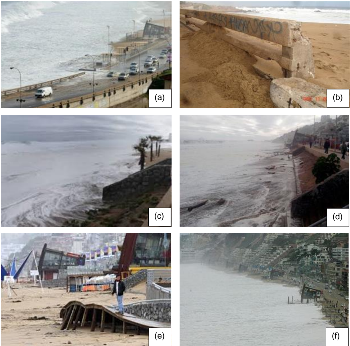
Figura 5-11: Ejemplos de daños en Reñaca, marejada Agosto de 2015. (a) Av. Borgoño Sector 1, (b) Sector Sur playa Reñaca, (c) y (d) Zona entre sector 2 y sector 3, (e) Sector 2, (f) Vista de Sur a Norte playa Reñaca (Las Últimas Noticias, 2015)
