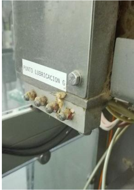
Figura 7.9 - Punto de lubricación.
