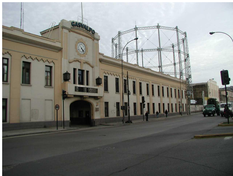
Figura 2.1.- Gasómetro (Barón). Fuente: http://gasvalpo.cl
