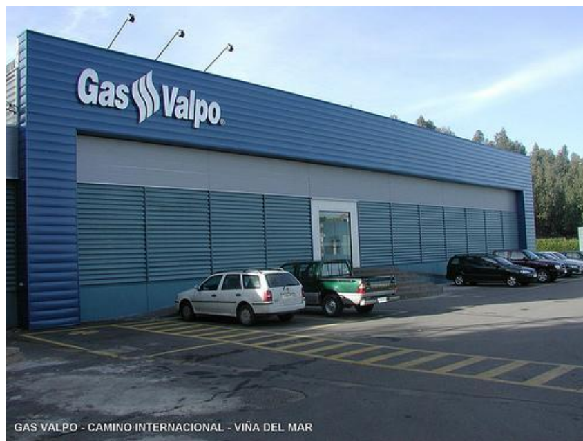
Figura 2.1.1.- Oficina Central en Camino Internacional. Fuente: http://gasvalpo.cl
