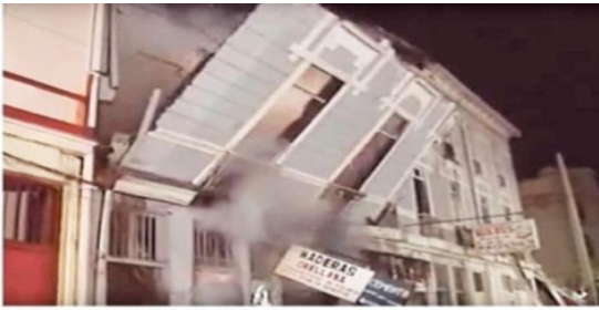
EL EDIFICIO SE DERRUMBÓ ESA MISMA MADELAGADA.
